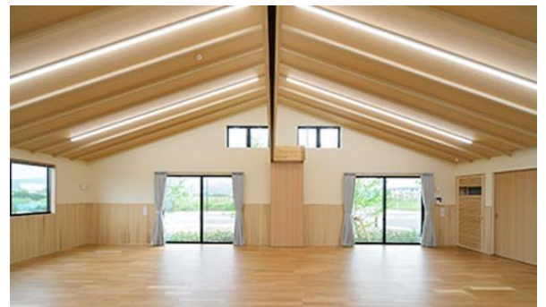
SE構法による施工事例（開成自治会館）
